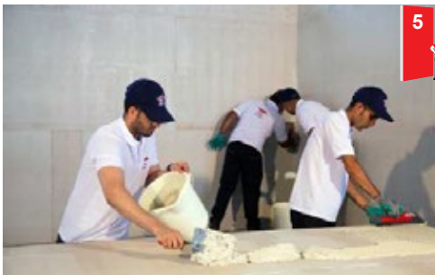
۵ • اعمال چسب به روش combined (هم بر روی سطح و هم در پشت اسلب)
