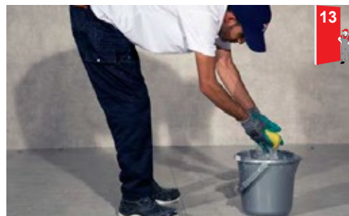
• نظافت بندها پس از بندکشی با پدهای اسفنجی با رطوبت بسیار کم
