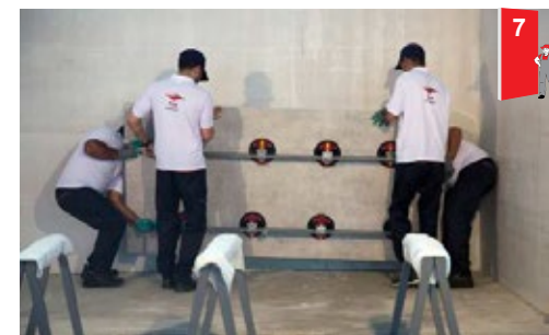
۷ • قرار دادن اسلب بر روی سطح (استفاده از استراکچر قابی حمل مجهز به قاپک مکنده جهت حمل)
