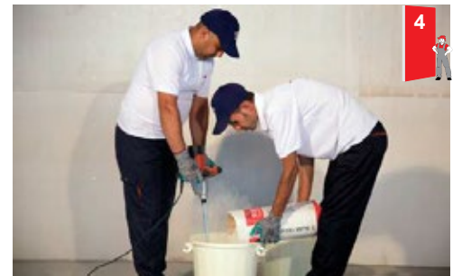
۴ • آماده کردن چسب با استفاده از میکسر
