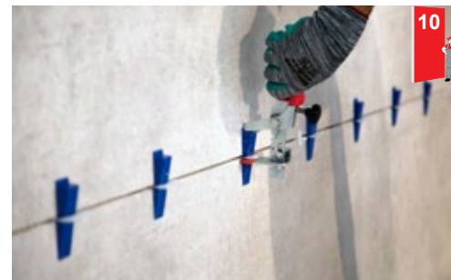
• استفاده از کلیپس و گوه همتراز کننده جهت اطمینان از هم سطح بودن سرامیک های مجاور
