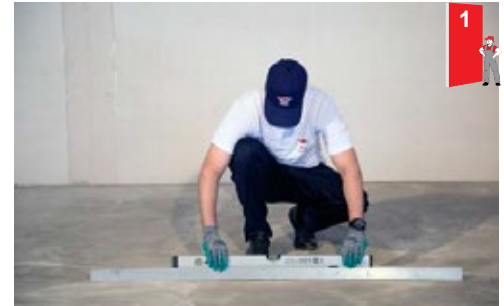
۱ • کنترل تراز بودن و هموار بودن سطح زیر کار
