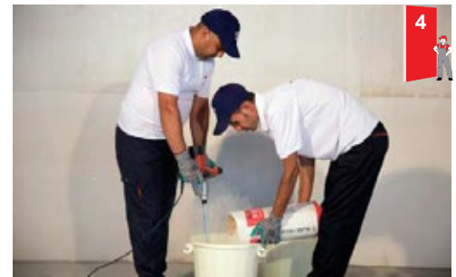
۴ • آماده کردن چسب با استفاده از میکسر
