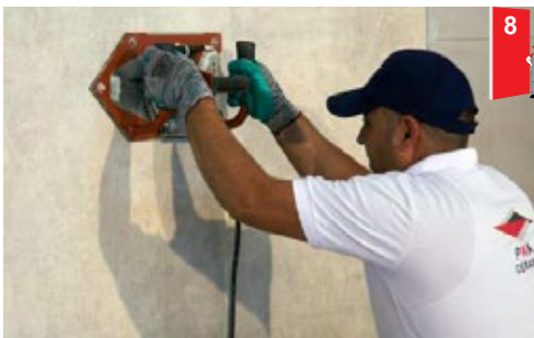
۸ • استفاده از ویراتور (یا مالیه لاستیکی) جهت اطمینان از چسبندگی مناسب اسلب به سطح زیر کار و نیز خروج هوا
