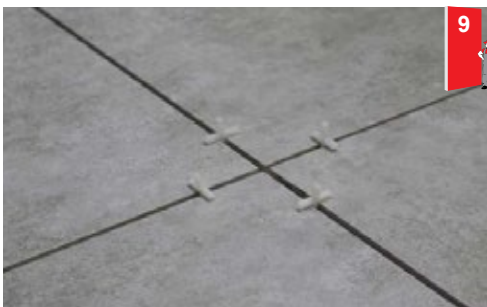
۹ • استفاده از اسپیسر (صلیب) جهت دستیابی به بندهایی با عرض یکسان
